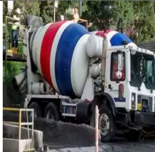
Fotografía 4. Lavado de vehículos mezcladores o mixers.
